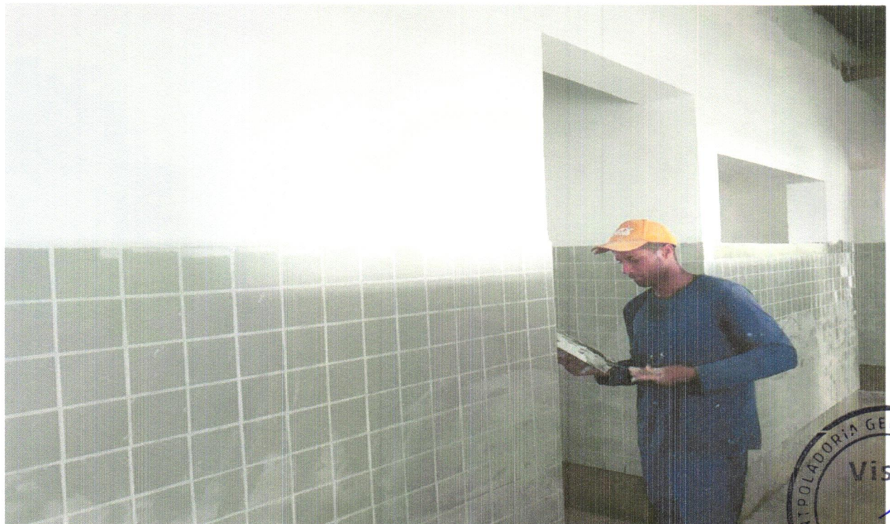
FOTO 24 - APLICAÇÃO E LIXAMENTO DE MASSA LÁTEX EM PAREDES, UMA DEMÃO. AF_06/2014
