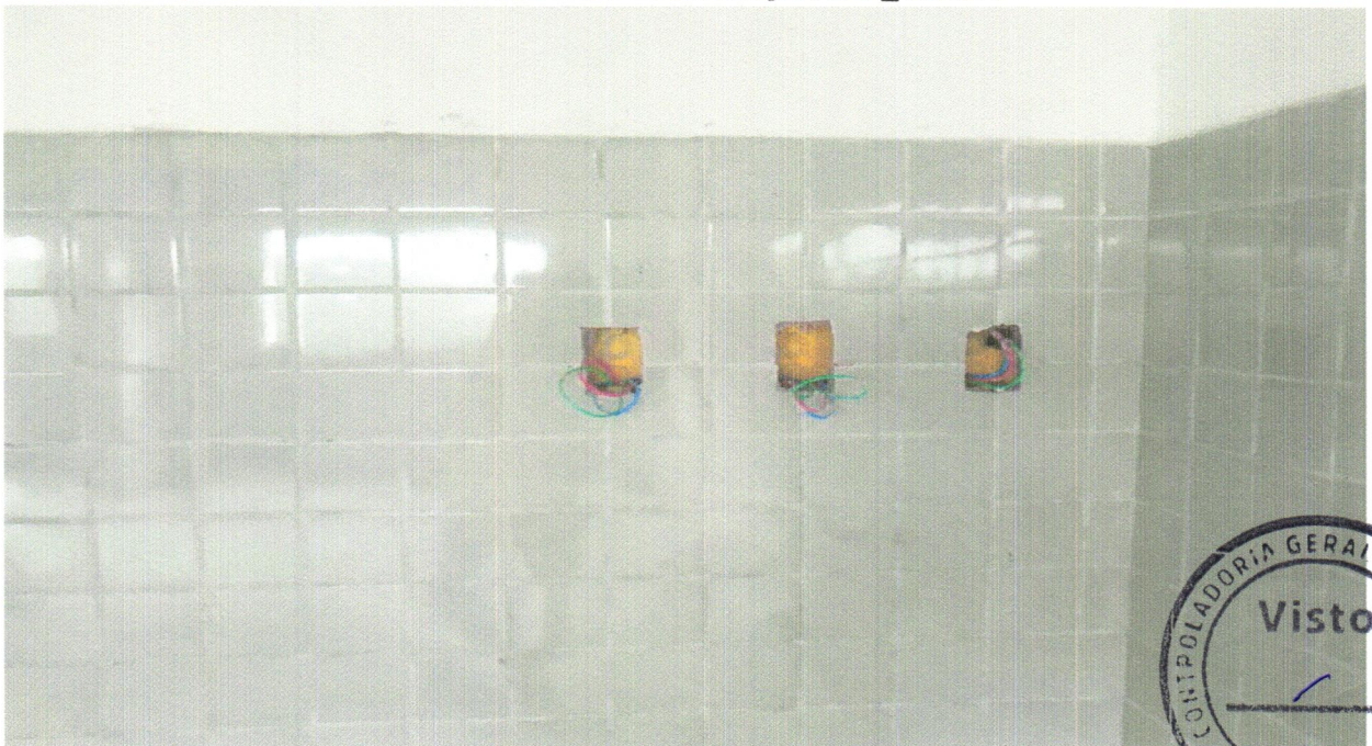
FOTO 14 - CABO DE COBRE FLEXÍVEL ISOLADO, 2,5 MM 2 , ANTI-CHAMA 450/750 V, PARA CIRCUITOS TERMINAIS - FORNECIMENTO E INSTALAÇÃO. AF_12/2015
