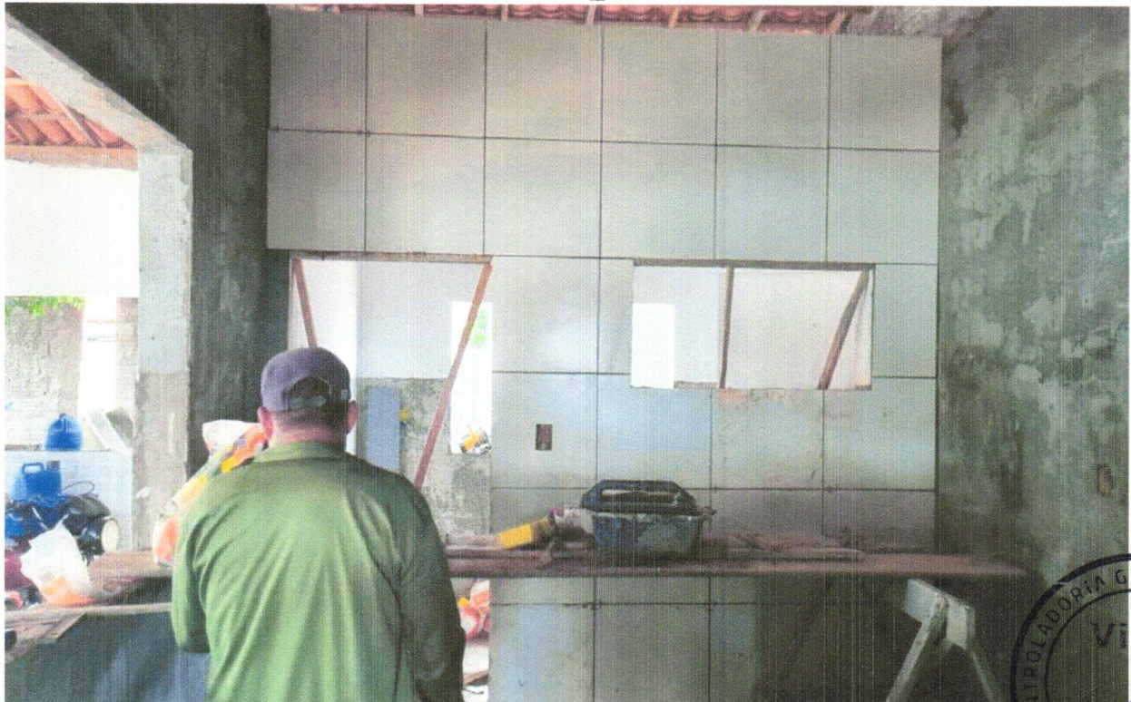
FOTO 16 - REVESTIMENTO CERÂMICO PARA PAREDES INTERNAS COM PLACAS TIPO ESMALTADA EXTRA DE DIMENSÕES 33X45 CM APLICADAS EM AMBIENTES DE ÁREA MAIOR QUE 5 M 2 NA ALTURA INTEIRA DAS PAREDES. AF_06/2014
