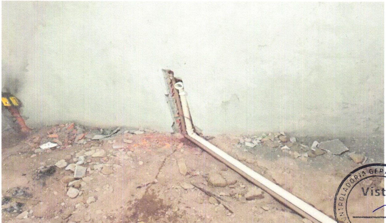
FOTO 06 - PONTO DE ESGOTO COM TUBO DE PVC RÍGIDO SOLDÁVEL DE Ø 40 MM (LAVATÓRIOS, MICTÓRIOS, RALOS SIFONADOS, ETC...)
