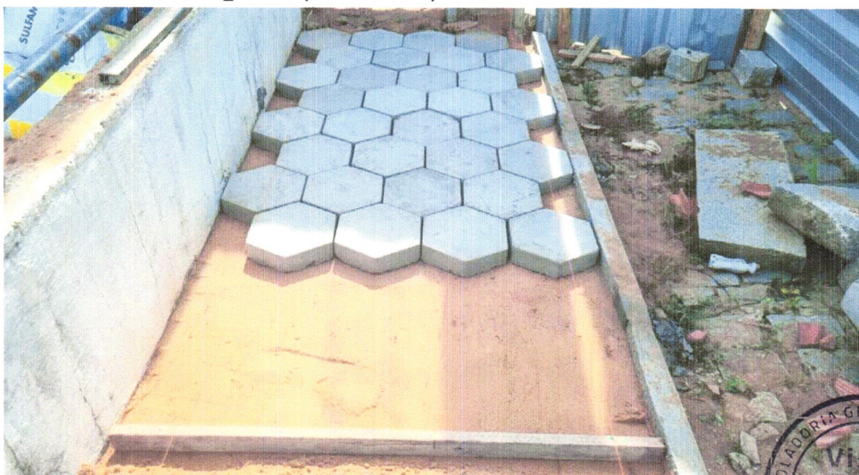
FOTO 20 - EXECUÇÃO DE PAVIMENTO EM PISO INTERTRAVADO, COM BLOCO SEXTAVADO DE 25 X 25 CM, ESPESSURA 8 CM. AF_12/2015 (COR NATURAL).
