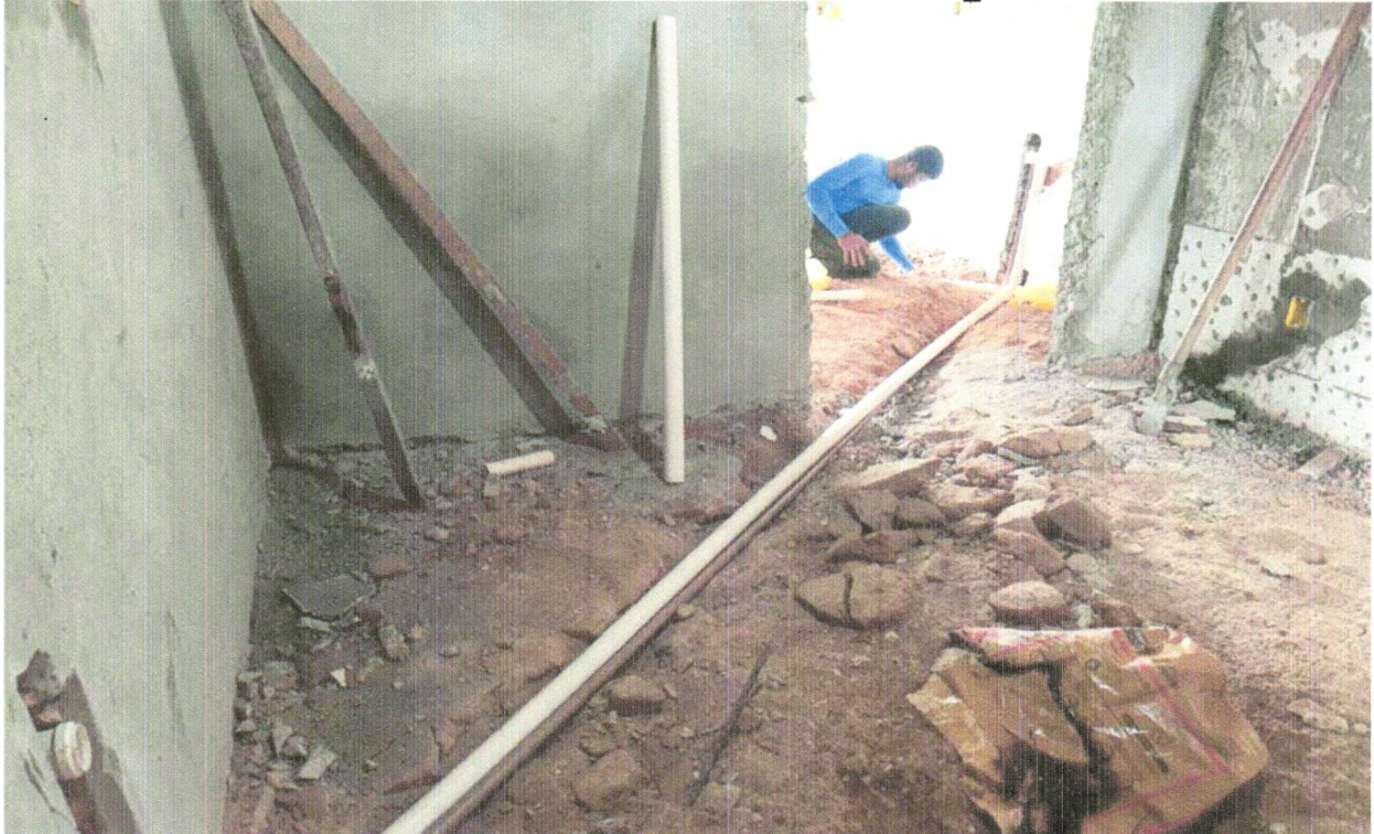
FOTO 10 - TUBO PVC, SERIE NORMAL, ESGOTO PREDIAL, DN 40 MM, FORNECIDO E INSTALADO EM RAMAL DE DESCARGA OU RAMAL DE ESGOTO SANITÁRIO. AF_12/2014
