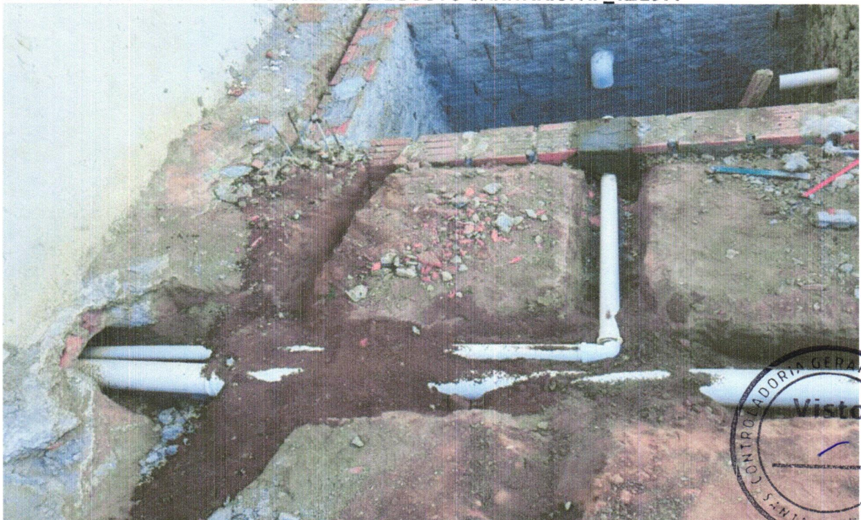
FOTO 10 - TUBO PVC, SERIE NORMAL, ESGOTO PREDIAL, DN 40 MM, FORNECIDO E INSTALADO EM RAMAL DE DESCARGA OU RAMAL DE ESGOTO SANITÁRIO. AF_12/2014
